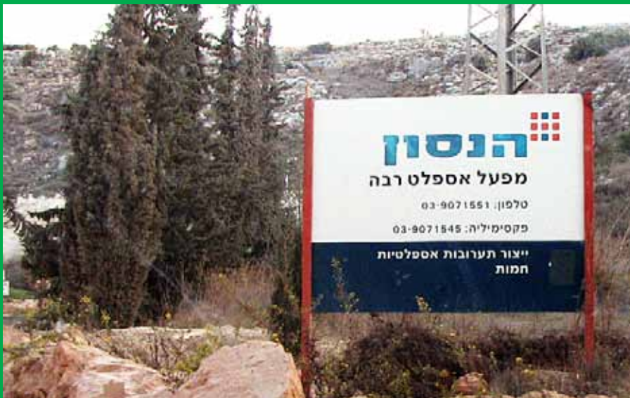
Nahal Ruba produksjonsanlegg for asfalt ved Cross Shomron Highway i november 2008. Foto: Dror
